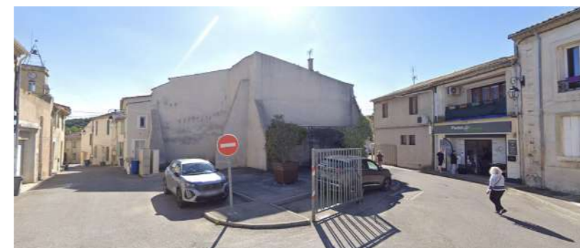
Curetage à l'articulation de la rue du château et la rue de l'Horloge
