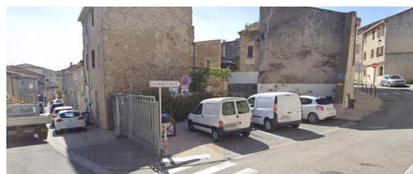
Curetage à l'articulation de la Grande Rue et de la Rue Menussargues
